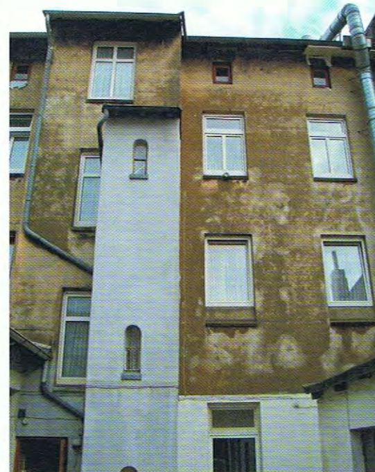
Rückansicht des Hauses heute. Die schmalen Fenster sind die Toilettenfenster. (Foto: Carola Siedhoff)
